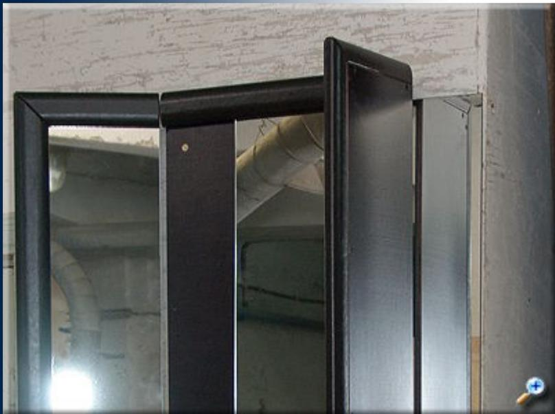
Производим тестовую сборку и навеску. Через подготовленные отверстия рама крепится непосредственно к стене. Затем со стороны одной из боковин (в полуоткрытом положении) задвигается центральное зеркало, закрывая собой крепежные шурупы и заднюю стенку.
